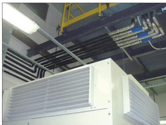
Obr. 2. Nad vzduchovým transformátorem 10,5 kV vede plastového potrubí s vodou (foto k otázce číslo 2)
