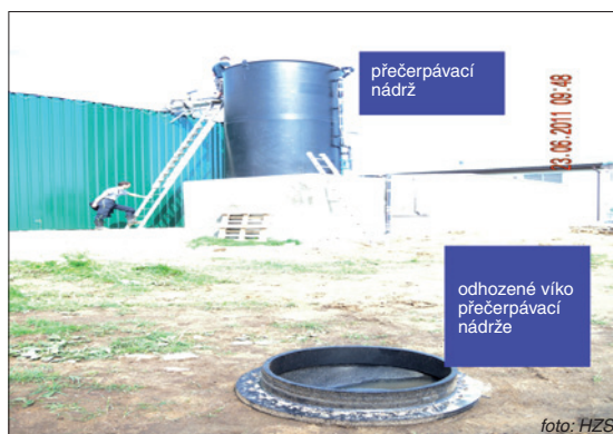
Obr. 5. Odhozené víko přečerpávací nádrže po výbuchu směsi
