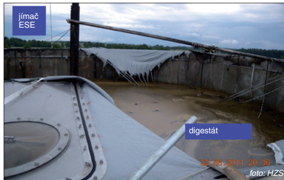
Obr. 6. Pohled do poškozené vnitřní jímy fermentoru, která se celá nachází v ochranném prostoru jímače ESE
