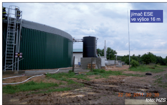
Obr. 7. Celkový pohled na umístění jímače ESE, který je vzdálen 13m od okraje fermentoru
