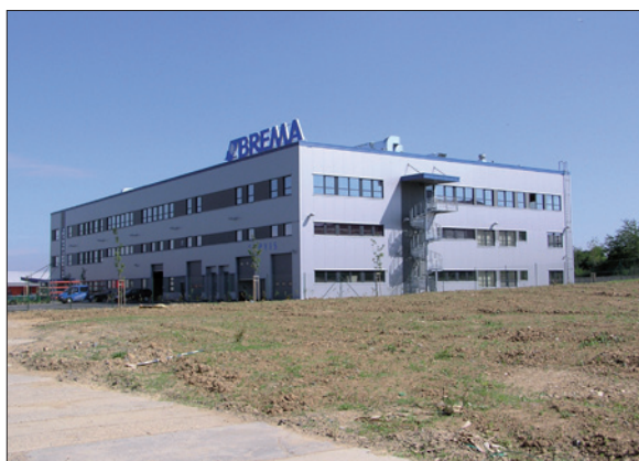
Obr. 2. Ve výrobní hale společnosti Brema bylo systémem WAGO řízeno 1 200 svítidel s předřadníkem DALI
