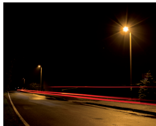
Obr. 4. Komunikace třídy S3 – průjezd vesnicí
