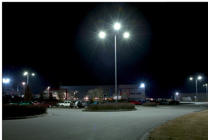
Obr. 2. Centrální parkoviště logistického areálu firmy Jipocar, stožáry výšky 14 m, svítidla Dolphin 120 W
