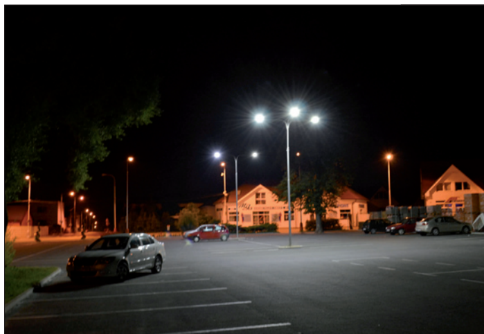
Obr. 5. Parkoviště v Mnichově Hradišti, ulice Turnovská; osvětleno svítidly Zenaro Dolphin 90 W
