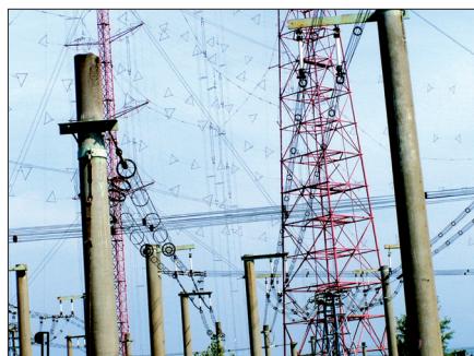
Obr. 1. Časť zložitých anténových systémov rozhlasového vysieláča v Rimavskej Sobote (napájací rozvod i samotná anténa)
