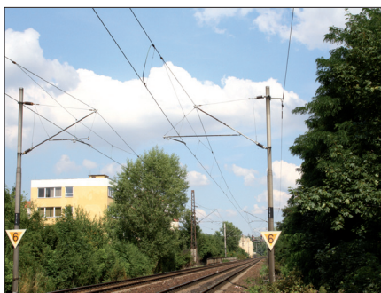
Obr. 1. Železniční trať elektrifikovaná stejnosměrnou proudovou soustavou 3 kV
