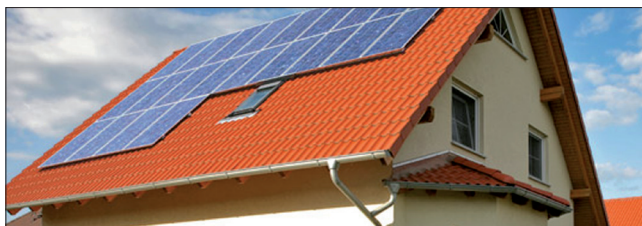
Obr. 1. Fotovoltaický systém na střeše rodinného domu
