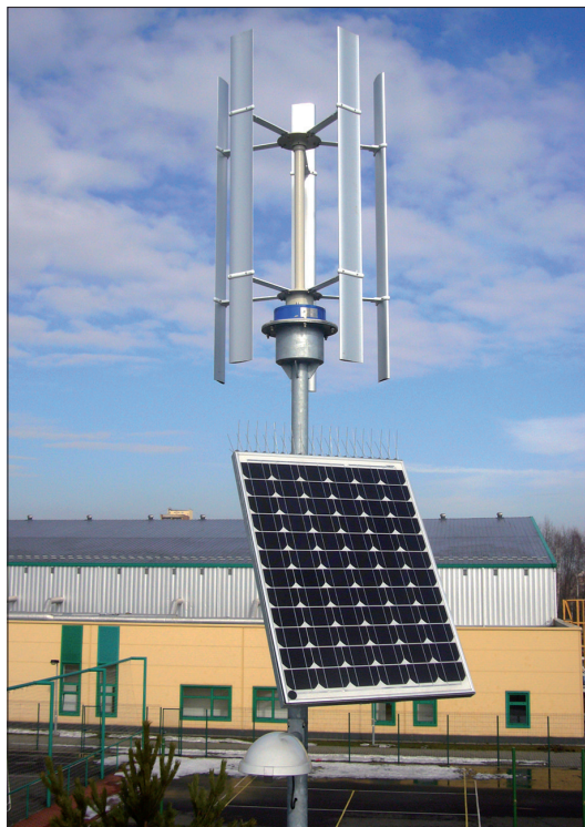
Obr. 4. Hybridní systém s vertikální větrnou elektrárnou
