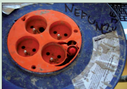
Obr. 2. Nebezpečný, přesto dále používaný prodlužovací kabel
