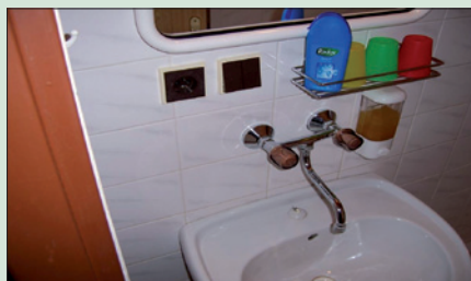
Obr. 1. Elektrická instalace v umývacím prostoru provedená v rozporu s předpisy
