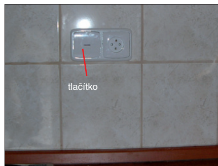
Obr. 2. Ovládání oběhového čerpadla
