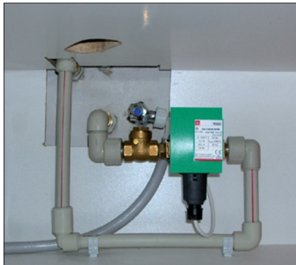
Obr. 1. Umístění oběhového čerpadla pod dřezem
