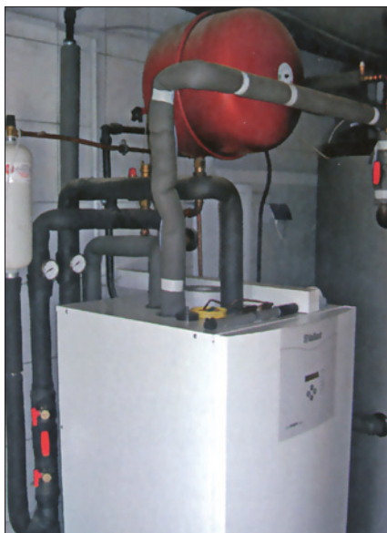
Obr. 1. Tepelné čerpadlo solanka-voda s přípojkami
