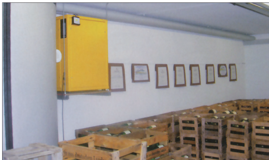
Obr. 3. Chlazení vinného skladu pomocí splitového teplovodního tepelného čerpadla
