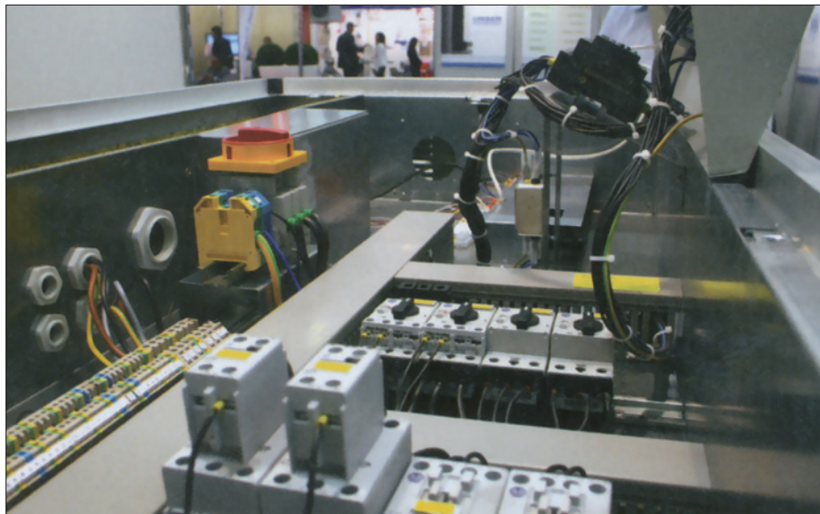
Obr. 2. Ovládací skříň tepelného čerpadla ústředního vytápění pro podnikatelské požadavky
