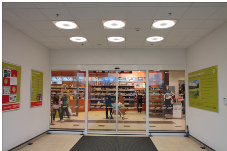
Obr. 4. Osvětlení vstupu LED svítidly Dayzone
