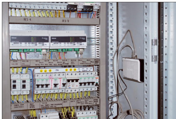
Obr. 3. Pohľad do rozvádzača s radiaciami a istiacimi prvkami osvetlenia
