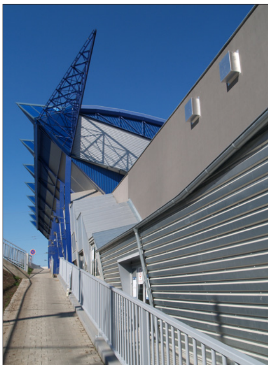
Obr. 4. Pohľad na vstup do novej haly, v pozadí hlavná hala
