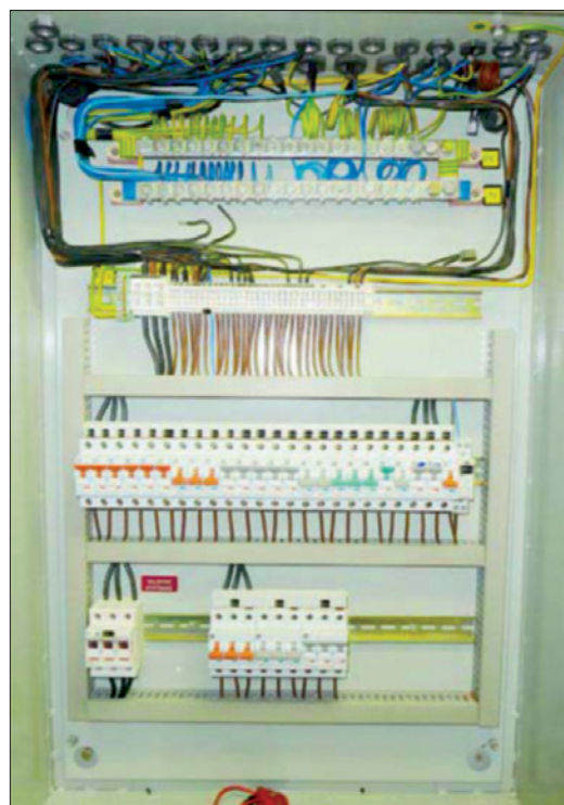
Obr. 2. Příklad rozváděče bez masky
