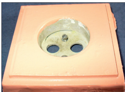
Obr. 2. Poškodený kryt zásuvky
