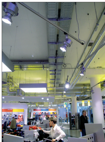
Obr. 2. Kabelové žlabu RKSM6 pod stropem nákupního centra
