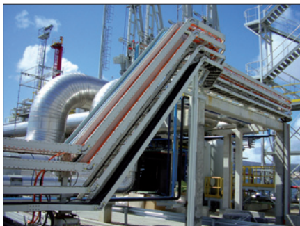
Obr. 1. Kabelové žebříky WKL pro velká rozpětí v energetickém průmyslu
