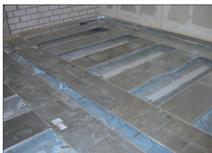
Obr. 6. Pokládka otevřených podlahových kanálů OKA v technologické místnosti
