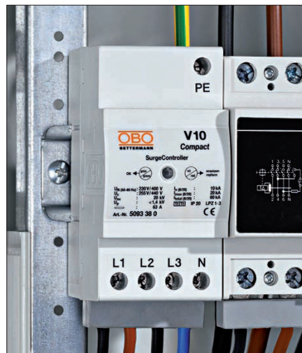
Obr. 2. Svodič přepětí typu 2 pro soukromé podružné rozvody
