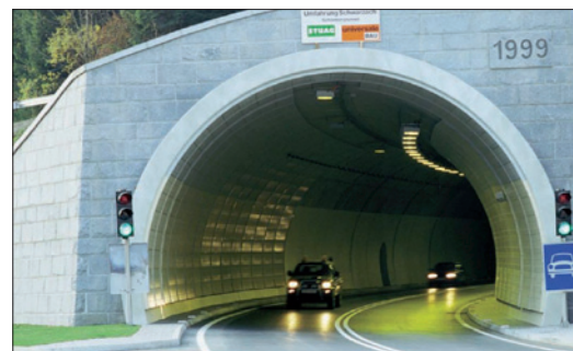
Obr. 5. Tunel Schönberg – v ústí tunelu je stále místo pro vysokotlaké sodíkové výbojky
