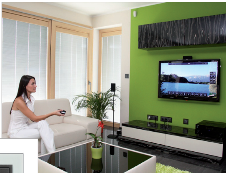
Obr. 7. Inteligentní systém elektroinstalace iNELS v praxi
