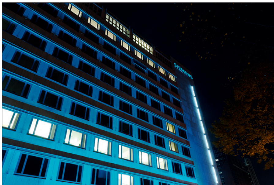
Obr. 4. Automatické a efektivní řešení osvětlení budov
