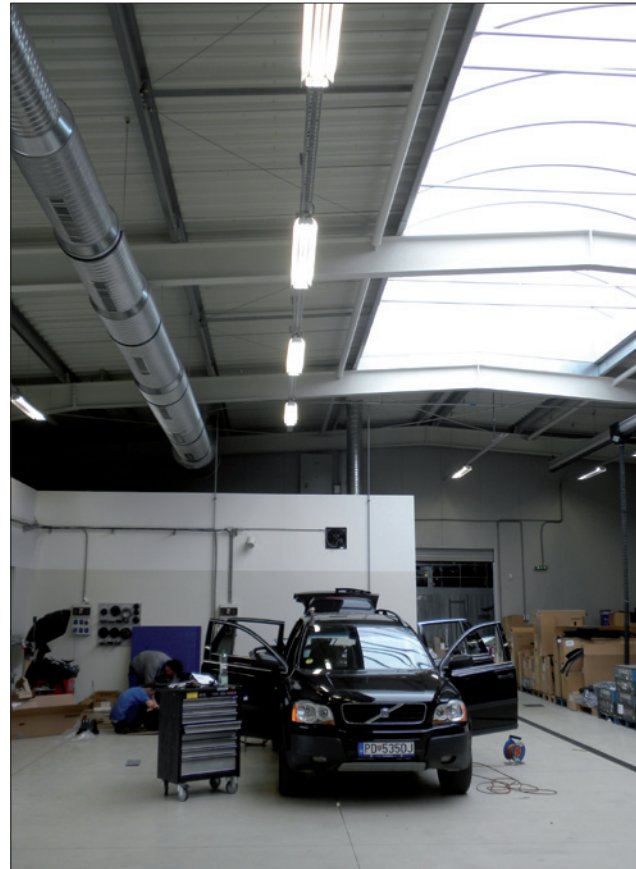
Obr. 5. Na osvetlenie servisnej časti sú použité úspešné svietidlá Fagerhult Induline T5 FDH 2x 80 W
