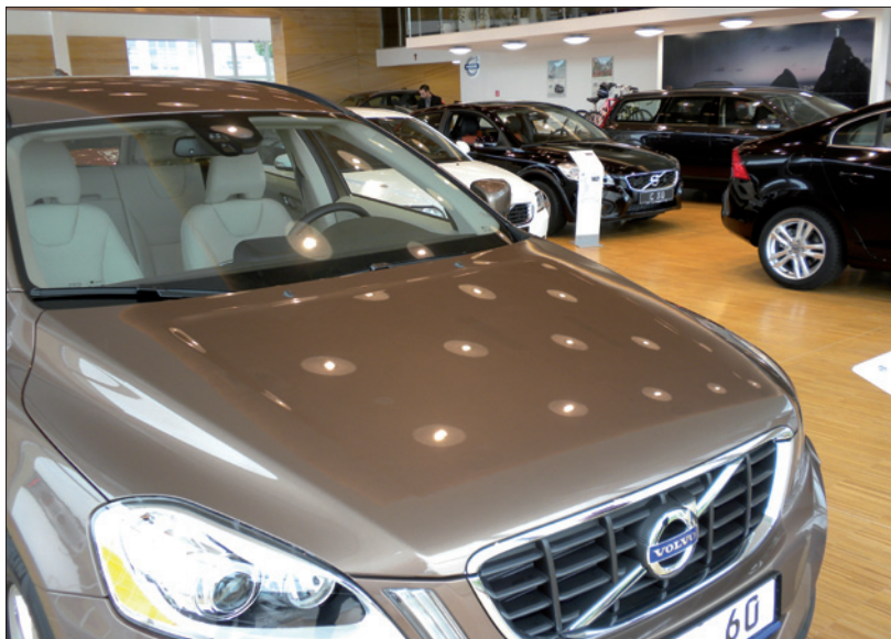
Obr. 10. Zrkadlenie sa svietidiel Pozzo II MT 1x 70 W na kapote auta, v pozadí svietidlá Teres, zdroj FCH 1x 60 W
