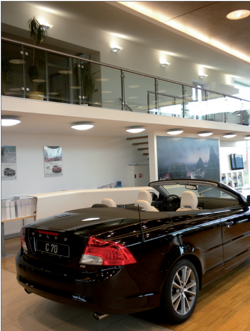
Obr. 3. Na galérii sú osadené svietidlá Wall Haze so zdrojom FSM-E 1x 32 W pre priamo-nepriame osvetlenie
