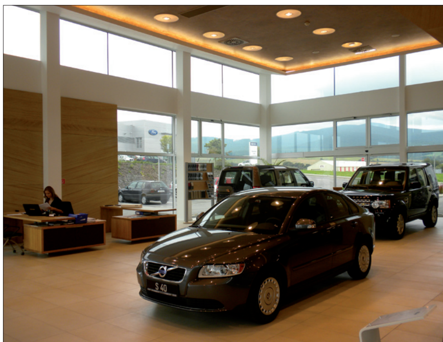
Obr. 2. Svietidlá Pozzo II a nepriame osvetlenie v strope so svietidlami Basic T5 FDH 1x 80 W
