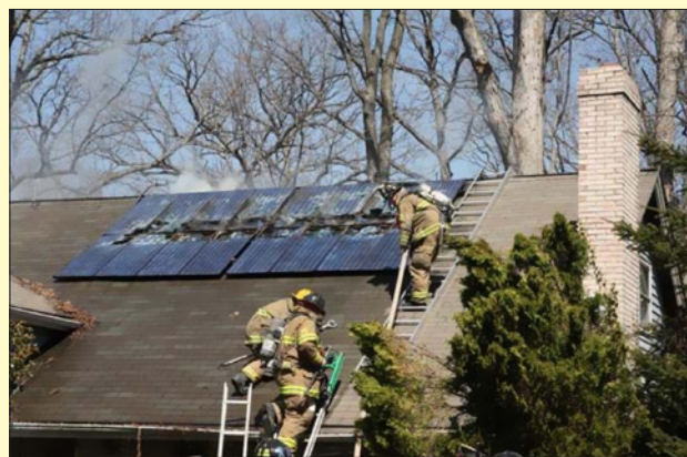
Obr. 2. Požár rodinného domu s fotovoltaičkou ve státě Maryland (USA)
