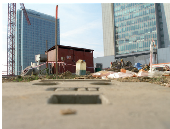
Obr. 2. Ilustrační foto (otázka 6) k problémům s přístupností k elektrickým zařízením na stavbách
