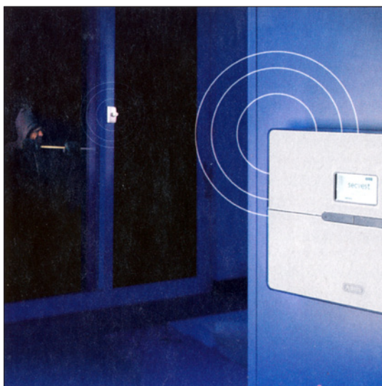
Obr. 9. Aktivní ochrana: zloděj je prozrazen mnohem dříve, než se mu podaří vloupat do objektu
