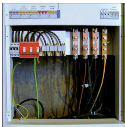
Obr. 3. Hlavní rozváděč – svodič SPD typu 1
