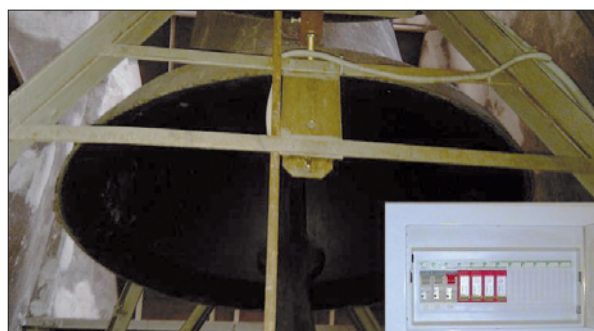
Obr. 5. Podružný rozváděč zvonů – svodič přepětí SPD typu 2
