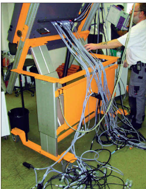
Obr. 2. Montáž kabelů v 24voltovém rozváděči finišeru Vögele
