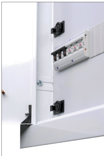
Obr. 6. Hloubková korekce zazdění vany
