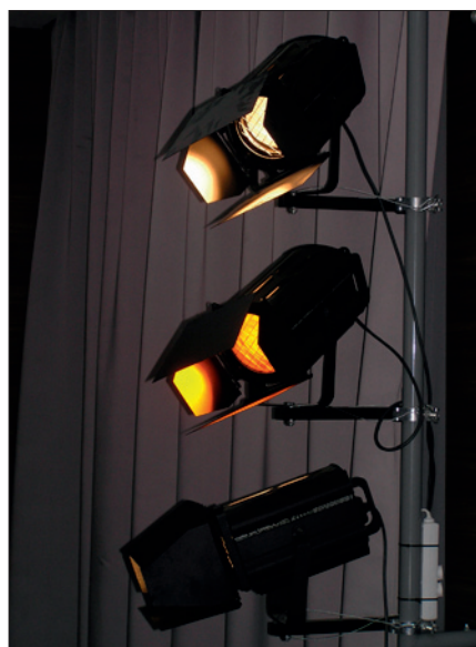
Obr. 2. Scénické konvenční světlo LDR NOTA PC 1200 Plus na svislé sálové tyči
