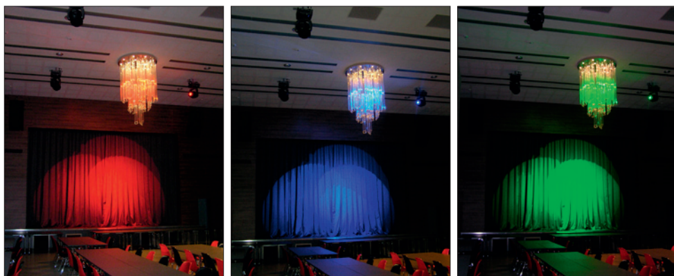
Obr. 6. Nasvícení jeviště a stropu sálu s lustrem inteligentními světloemety Coemar, vybavenými integrovaným motorovým barevným měničem se šesti jasnými barevnými filtry + bílá
