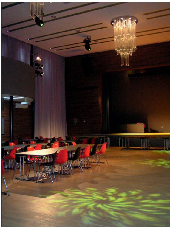
Obr. 4. Světlomety LDR osvětlují jeviště, inteligentní světlomety Coemar vytvářejí barevná goba na podlaze
