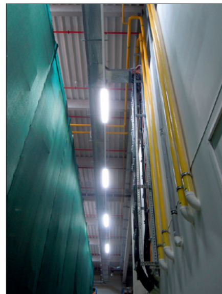
Obr. 3. Testování trubcových LED zdrojů LightDec s reflektorem s úhlem poloviční svítivosti 70° z výšky 10 m v logistické hale, zde byla naměřena o 30 % větší intenzita osvětlení
