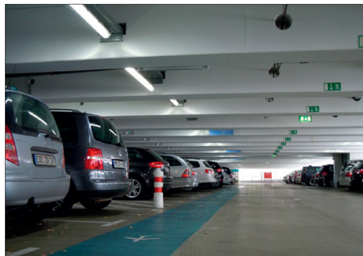
Obr. 2. Osvětlení garáže mnichovského letiště; zde výrobky značky LightDec vyhrály veřejnou soutěž z celkového počtu třinácti nabídek
