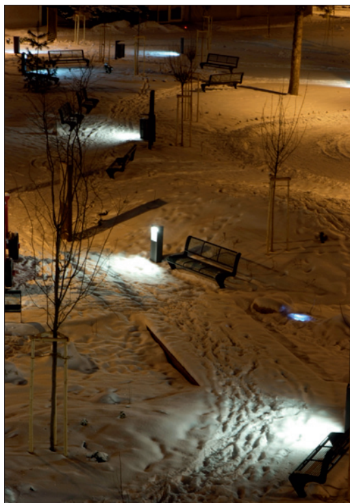
Obr. 5. Typické rozložení světla svítidel Compatta 5022 s kompaktní zářivkou 26 W
