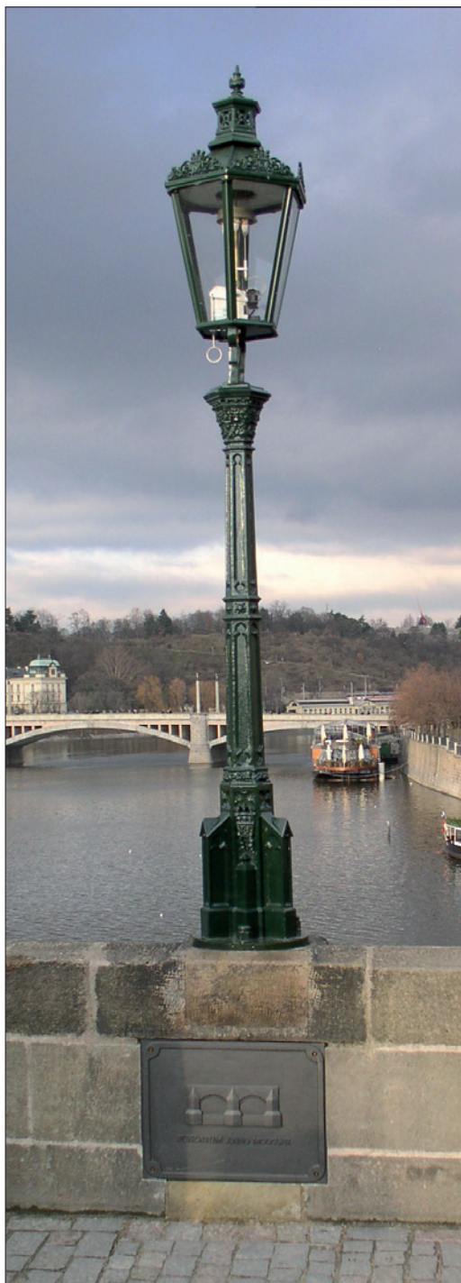
Obr. 8. Plynová lucerna HL 052 GAS na parapetním stožáru na Karlově mostě
