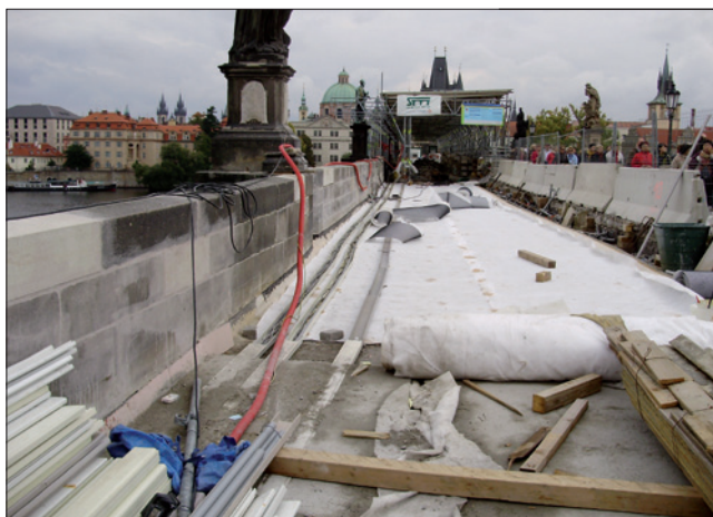
Obr. 7. Most musel po celou dobu rekonstrukce zůstat přístupný veřejnosti
