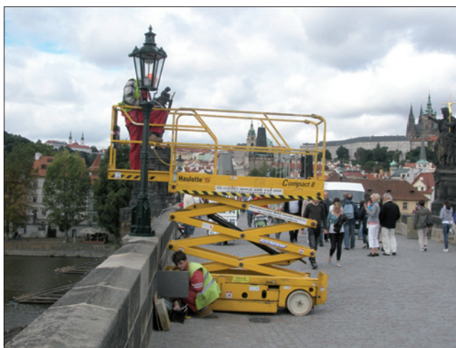
Obr. 6. Montáž plynové lucerny na Karlově mostě
