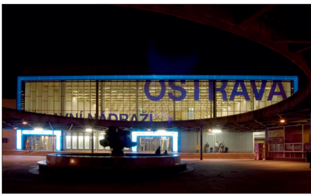
Obr. 5. Volba osvětlovací techniky – použití světelného kabelu v portálu místo 80 samostatných světelných zdrojů (Hlavní nádraží Ostrava)
