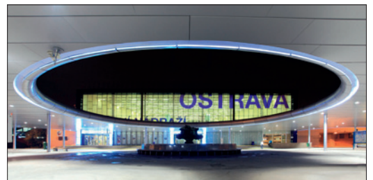
Obr. 6. Využití potisku hlavní prosklené fasády pro vytvoření různých vjemů v závislosti na denním či nočním osvětlení interiéru (Hlavní nádraží Ostrava)
