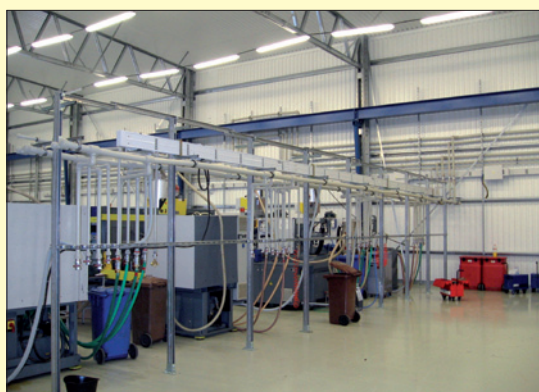
Obr. 1. Inteligentní elektroinstalace v lisovně plastů
