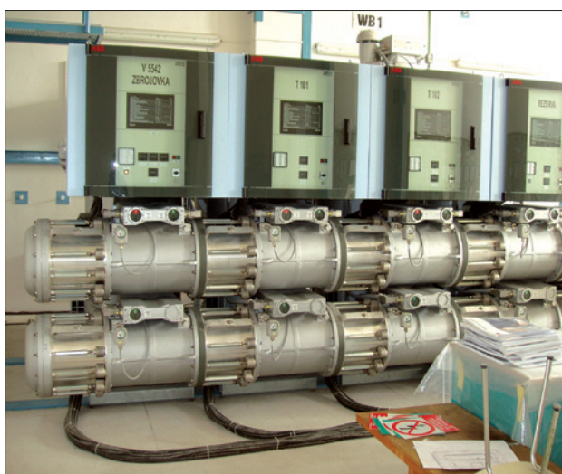
Obr. 2. Zapouzdřená rozvodna 110 kV (ve výstavbě)
