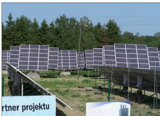
Obr. 1. Fotovoltaická elektrárna v Rožmitále
