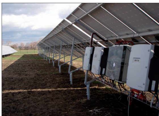
Obr. 2. Fotovoltaická elektrárna Měnin
