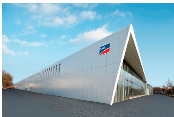
Obr. 1. Nová továrna na výrobu fotovoltaických střídačů SMA – Niestetal, Německo
