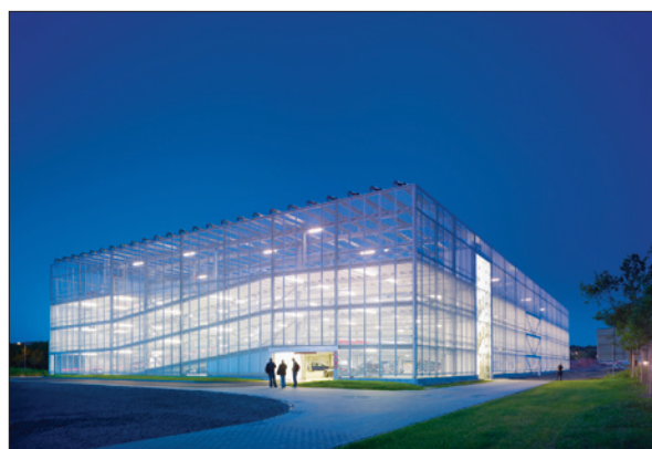
Obr. 3. Netradičně řešená je i budova garáží pro zaměstnance
