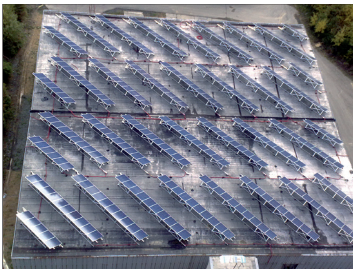
Obr. 1. Ukázka střešní instalace FVE o výkonu 100 kWp
