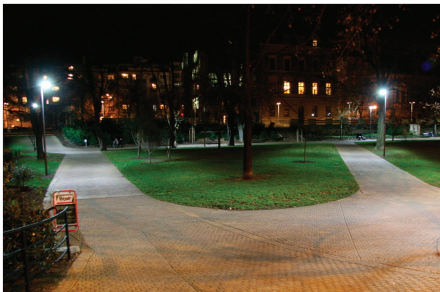
Obr. 1. Pilotní projekt LED, park Portheimka v Praze, svítidla Indal Stella, chladně bílá, v popředí osvětlení vysokotlakými sodíkovými výbojkami
