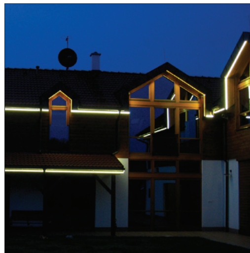
Obr. 2. Osvětlení rodinného domu na Rokycansku; pás je zde efektně instalován na hrany střechy a rovnoměrně nasvětluje komunikaci podél domu
