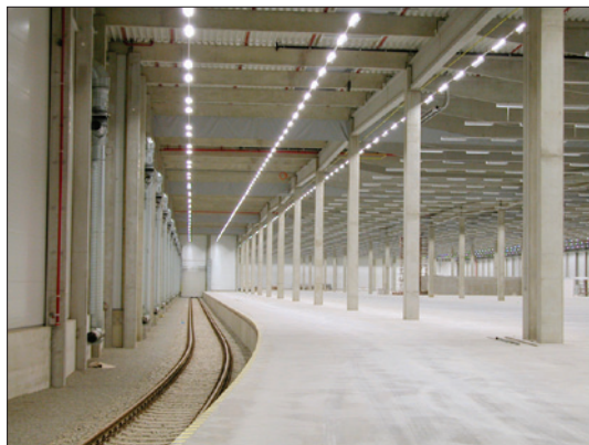
Obr. 1. Osvětlení kolejíště logistického centra ČD Cargo
