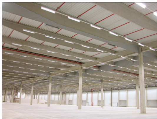
Obr. 2. Průběžné světelné řady lištového systému Carme 2× 49 W
