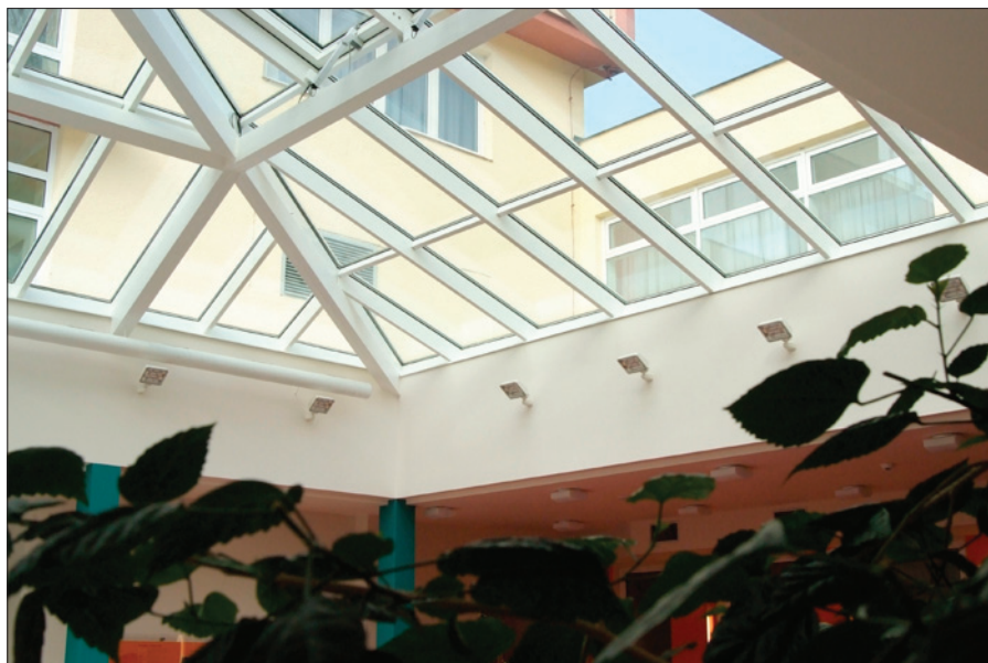
Obr. 3. Atrium osvětlené svítidly Fluospot PC 49
