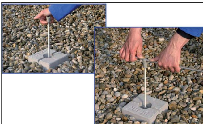
Obr. 1. Podpěra vedení na střechy DEHNiso-DLH – průběh montáže
