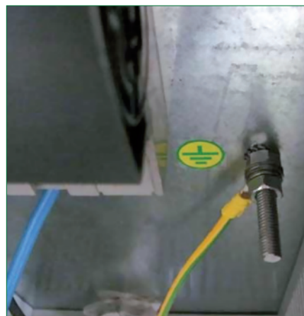
Připojení přívodního ochranného vodiče k rozváděči
