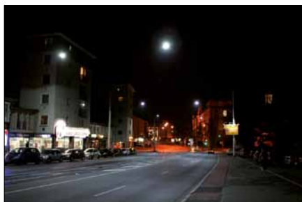
Obr. 1. Svítidlo Dolphin – instalace na laně – komunikace kategorie ME-2 (Darmstadt, Německo)
