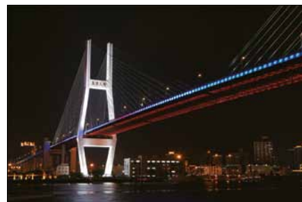
Obr. 3. Osvětlení mostu Nanpu při příležitosti výstavy Expo 2010 (Šanghaj, Čína)
