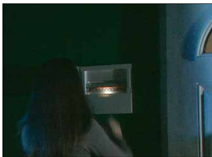
Obr. 1. Poziční světlo v rozvodnici Mini Pragma
