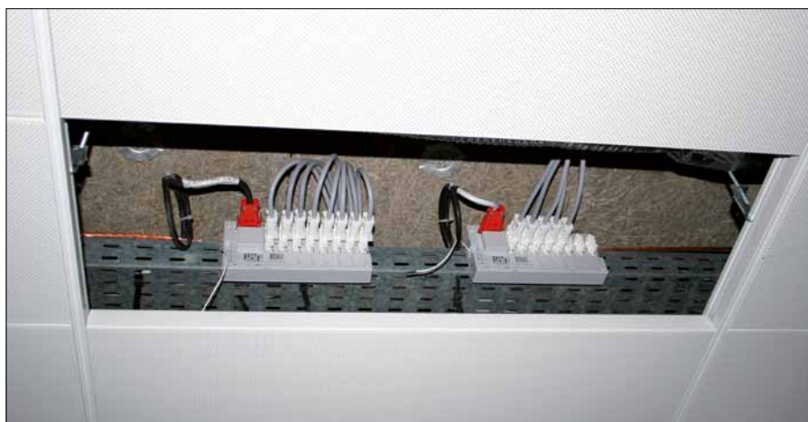
Obr. 5. Příklad instalace osmikanálových vysílačů 3299-84330
