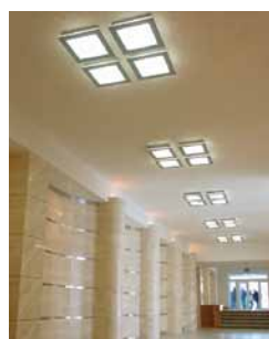
Obr. 8. Závesné svietidlo Conolux-A 30× 3 W LED
