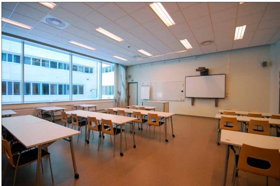
Obr. 2. Vzorová školní učebna s řízením osvětlení Helvar
